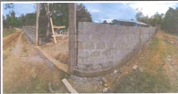
Foto:6 VISTA PREVIA DEL LADO DERECHA E IZQUIERDA LUEGO DE LA FINALIZACIÓN.
