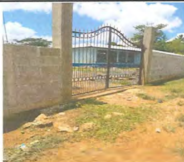
Foto1: CULMINACION Y VISTA PREVIA DE LA CULMINACIÓN DE LA ENTRADA A LA ESCUELA.
