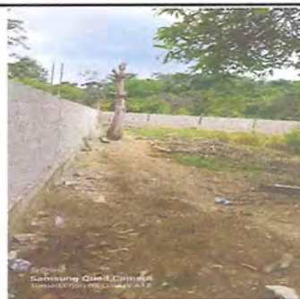
Foto 4: VISTA DESDE DENTRO DE LA ESCUELA, LUEGO DE LA FINALIZACIÓN DEL MURO.
